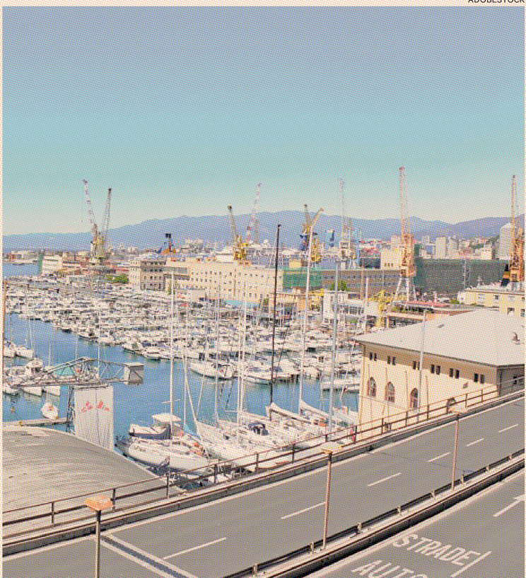
Opera da un miliardo. La Diga foranea consentirà al porto di Genova di ospitare in sicurezza navi più grandi senza limitare accessi e manovre verso gli accosti
